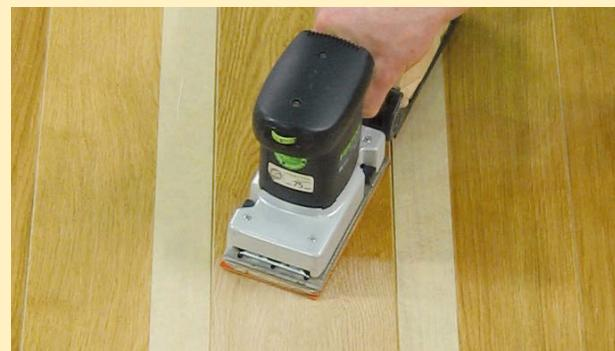
Slip den skadete overflaten grundig.
