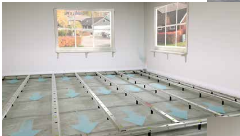
3. Granab Tilfarersystem med undergulvventilasjon og isolasjon monteres.
