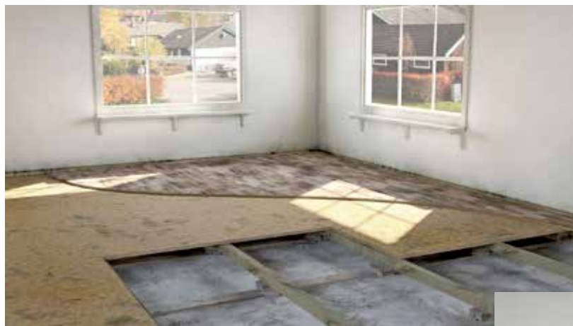
2. Betongplaten rengjøres for alt organisk materiale.
